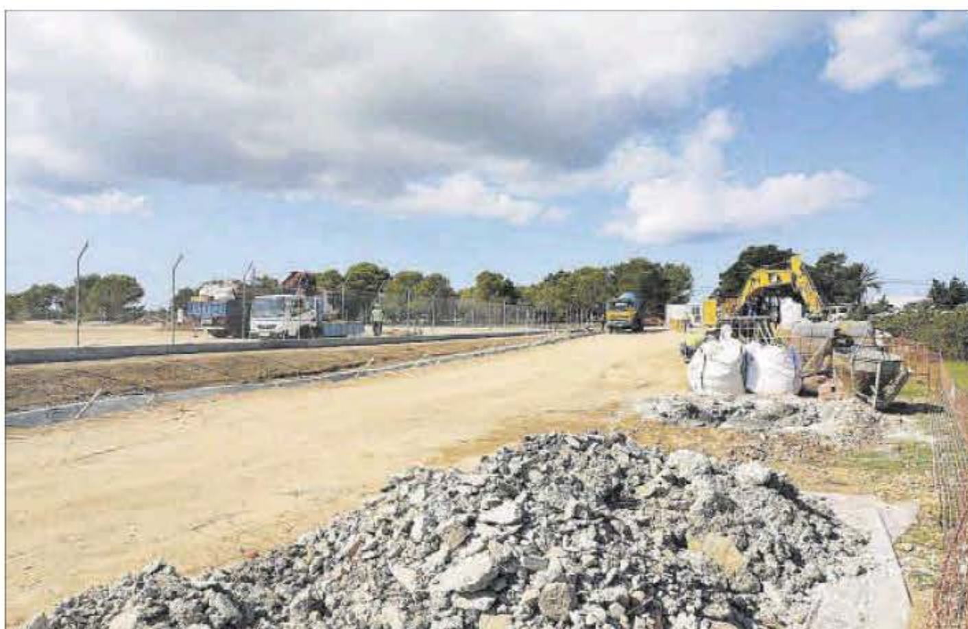
Obras de la nueva subestación eléctrica de Formentera en es Ca Marí.
