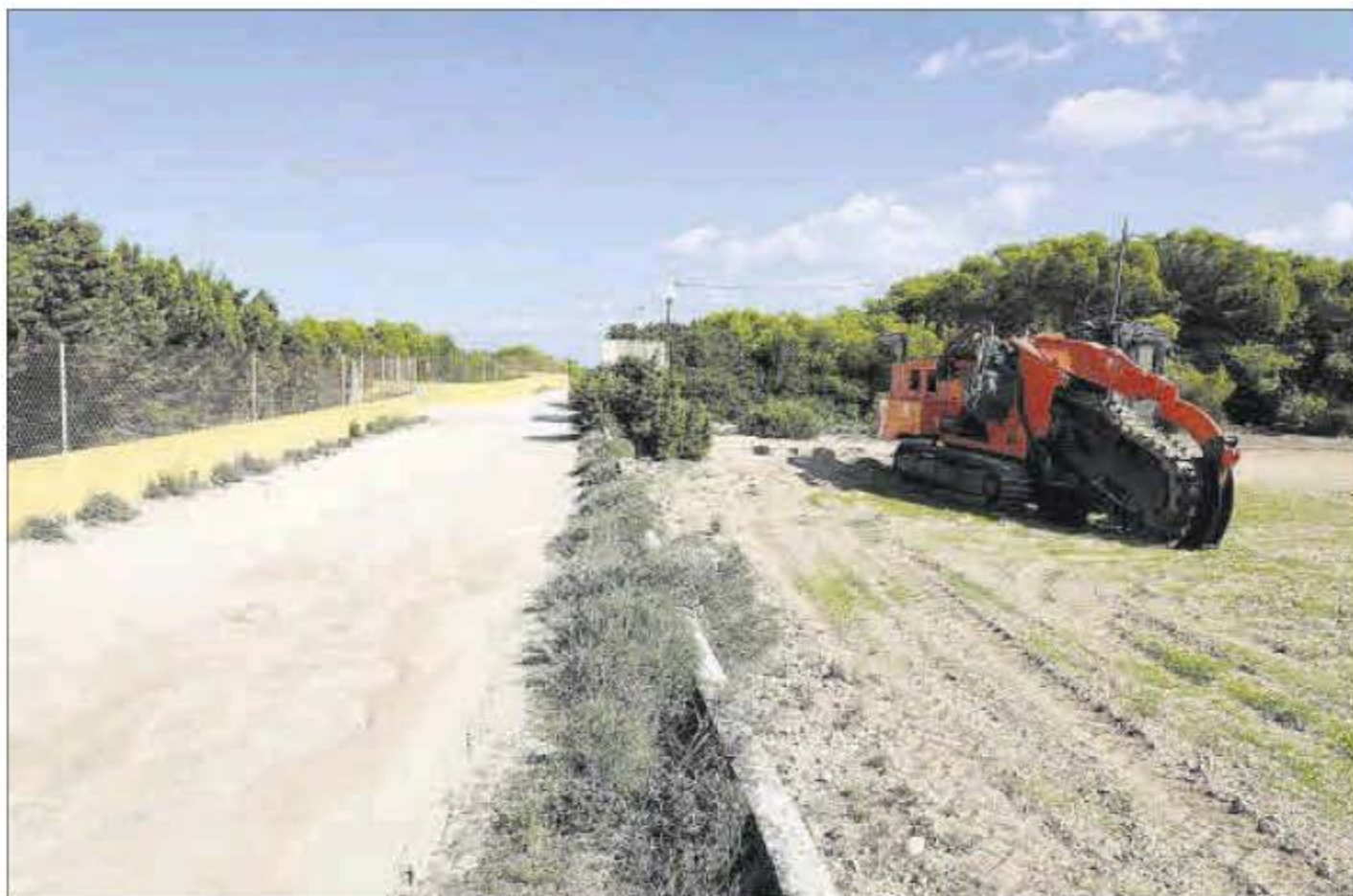
Camino por el que pasará el nuevo cable hasta conectar con la carretera principal.
